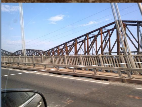
Photo 2 Pont du Québec over the St. Lawrence
